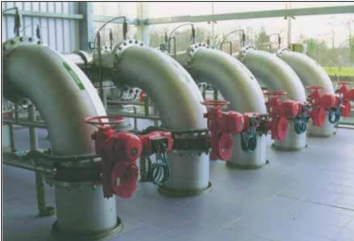
**Ч**етверть-оборотные приводы используются для управления шаровыми кранами, дисковыми затворами, воздушными заслонками и прочей арматурой, требующей поворотного движения менее одного оборота.
