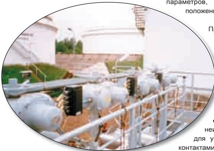
Приводу присваивается номер (адрес) для точной адресации команд.
